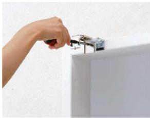
②ブラインドを取り付けた後、ウッドバランス裏面のバランスレールをバランスブラケットのツメに引っ掛け、はめ込みます。
