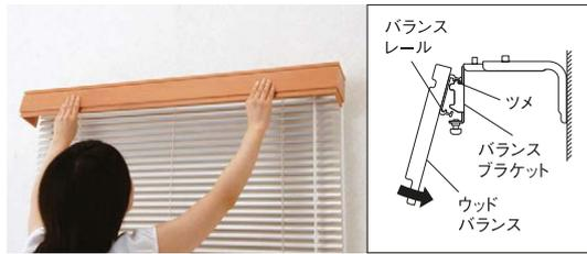
③バランスブラケットの固定ネジをドライバーで締め、バランスを固定します。
