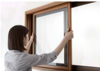
① 内窓を取外します。
