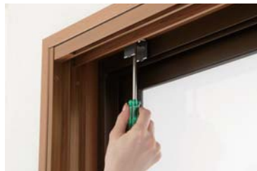
② ブラケットを取付けます。
